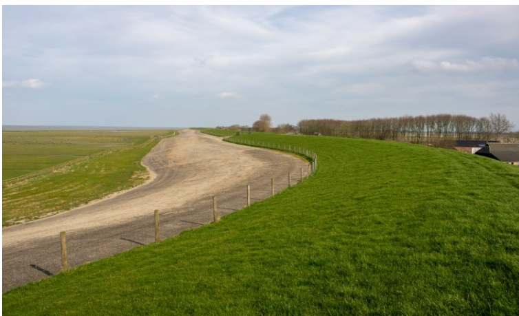
Afbeelding 4.6 Dijk in deeltraject 't Skoar (richting het oosten)
