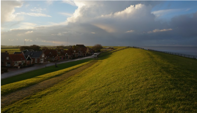
Afbeelding 4.18 Dijk in deeltraject Peazens-Moddergat (richting het noorden)
