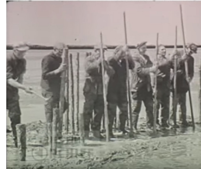
Afbeelding 2.2 De aanleg van rijshouten dammen (uit de film Van waddenzand tot vruchtbaar land)
