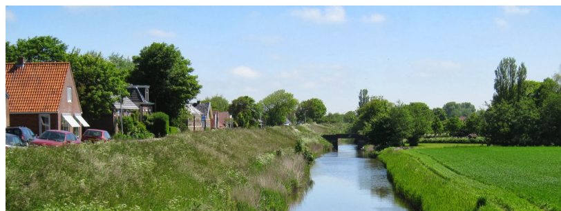
Afbeelding 2.8 De Nieuwe Bildtdijk, met de vaart en grote boerderijen ten zuiden van de dijk en de arbeiderswoningen aan de noordkant. (bron: videoblog Leeuwarder dagboek)
